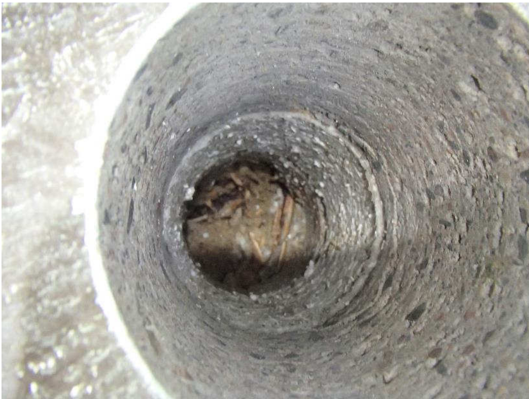
Kuva 132. Putkikanaalin betonivalun maanvastaisissa seinämissä on muottilauδοitukset paikoillaan.
