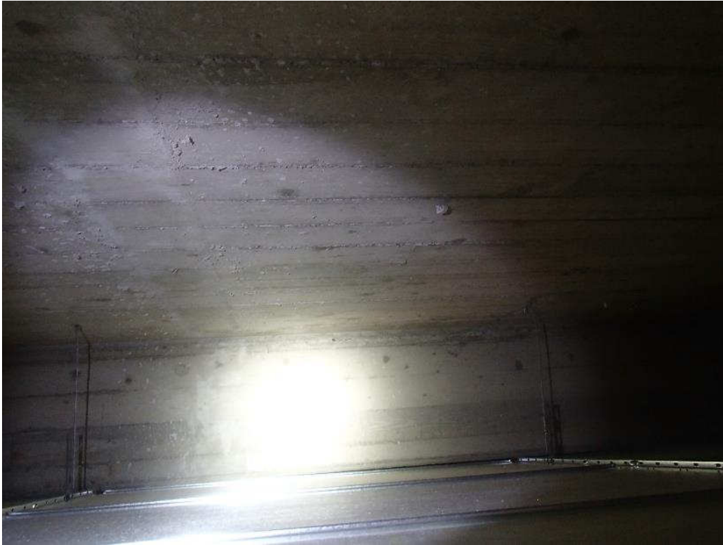
Kuva 57. 2.kerroksisen osuuden 1.kerroksen alakattojen ripustus.
