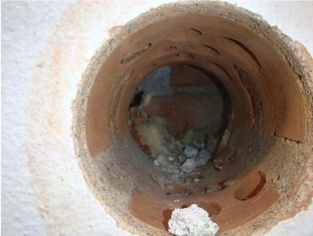
Kuva 7. Rakenneavaus vuonna 1967 rakennetun osan julkisivurakenteeseen luokkahuoneen 3 sisäpuolelta.
