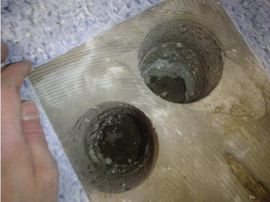
Kuva 127. Rakenneavaus työtila 58 alapohjaan ulkovaipparakenteen vierestä.
