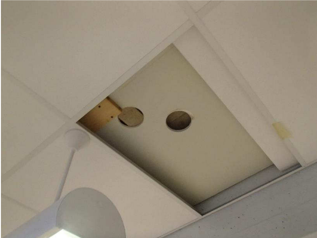
Kuva 54. Rakenneavaus alakattoon
