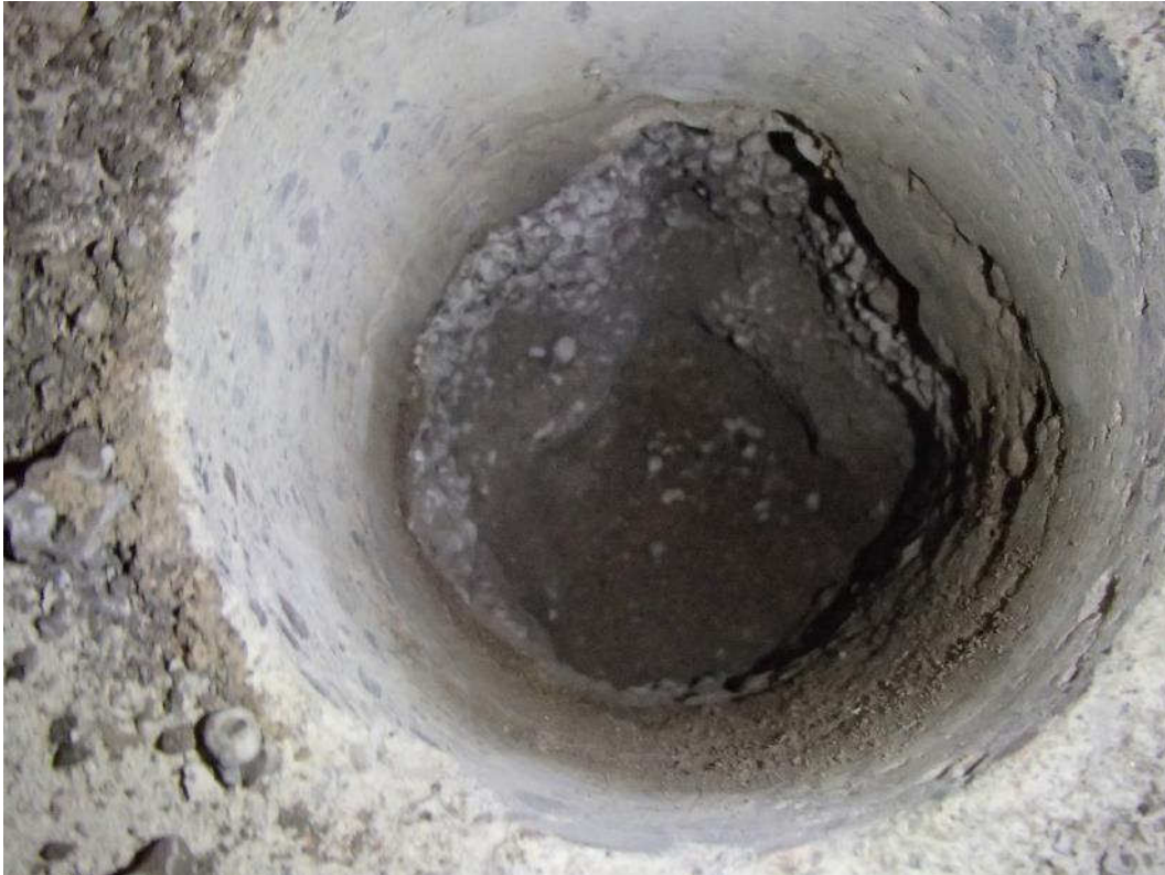
Kuva 82. Rakenneavaus luokkahuoneen 54 alapohjaan eteisen reuna-alueella.
