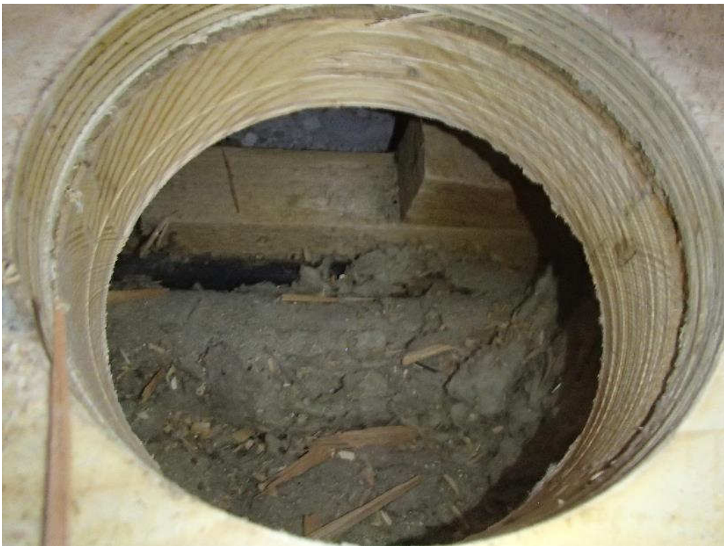
Kuva 84. Rakenneavaus kotitalousluokan alapohjaan.
