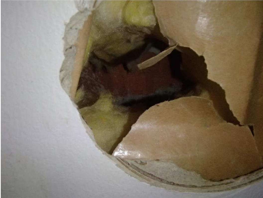
Kuva 36. Rakenneavaus valopihan väliseinään.
