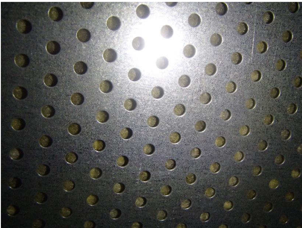
Kuva 146. Käsityöluokan alakatossa on reikälevy, jonka taustalla on mineraalivillat.
