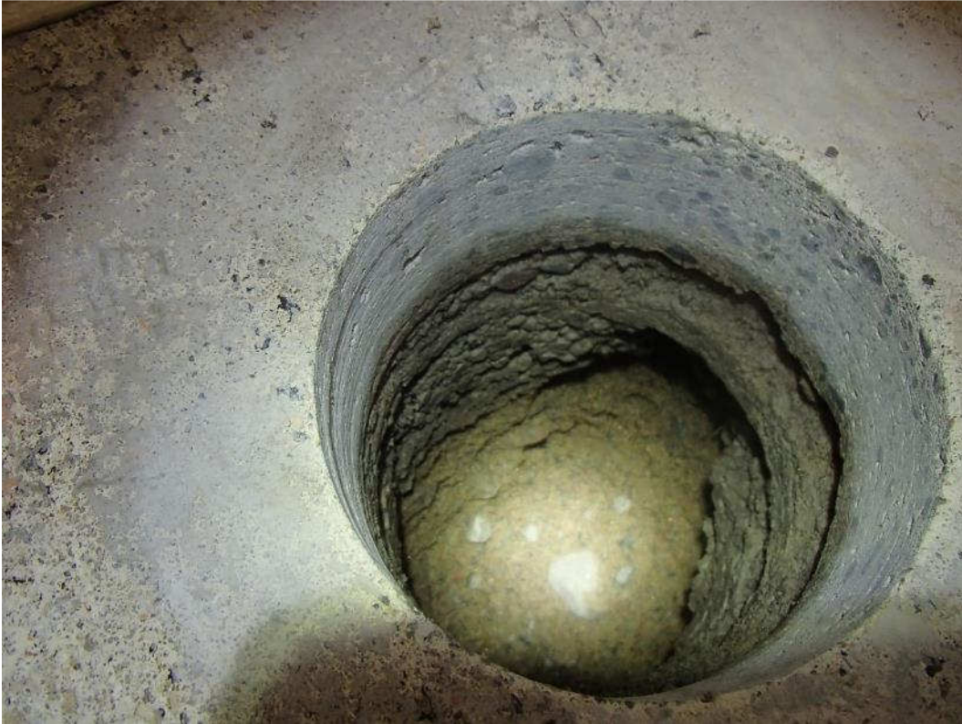
Kuva 78. Rakenneavaus luokkahuoneen 54 alapohjaan luokan keskiosalla.
