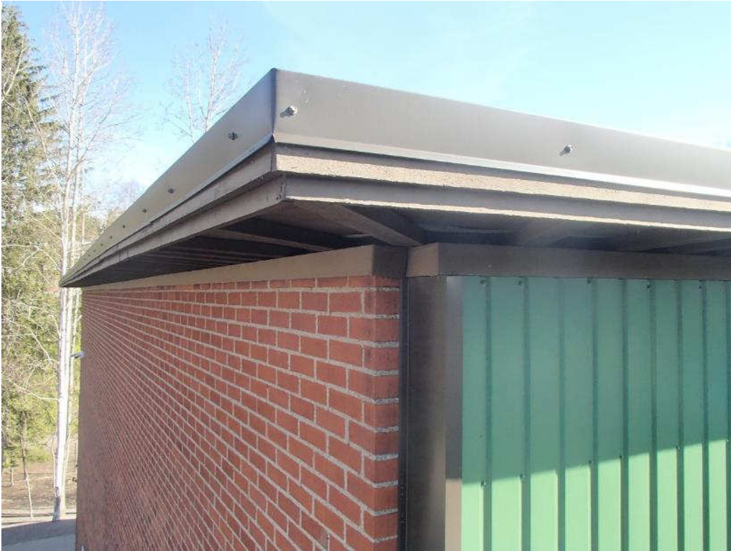
Kuva 52. Vuonna 2003 rakennettu räystäään jatkos.
