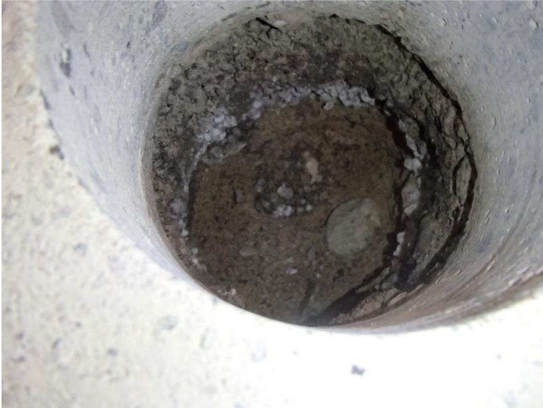
Kuva 81. Rakenneavaus luokkahuoneen 54 alapohjaan eteisen keskiosalla.
