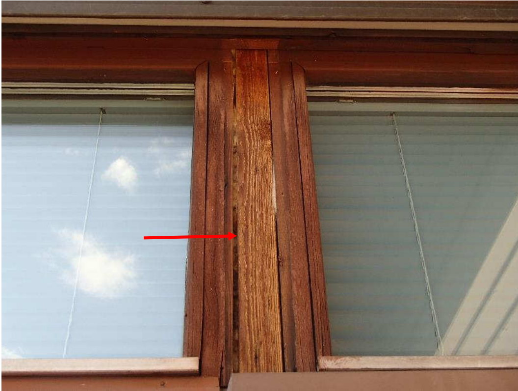
Kuva 110. Paikoin ikkunoiden apukarmit ovat esillä.
