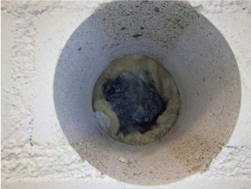
Kuva 87. Rakenneavaus maanastaiseen seinään naisten pukuhuoneesta.
