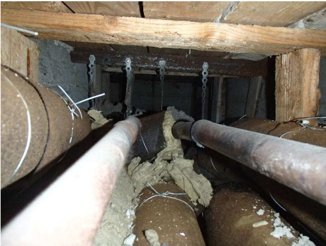
Kuva 131. Putkikanaalin sisällä on betonikannen muottilaudat.
