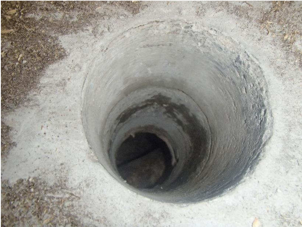
Kuva 126. Rakenneavaus työtilan 58 alapohjaan putkikanaalin kohdalta.
