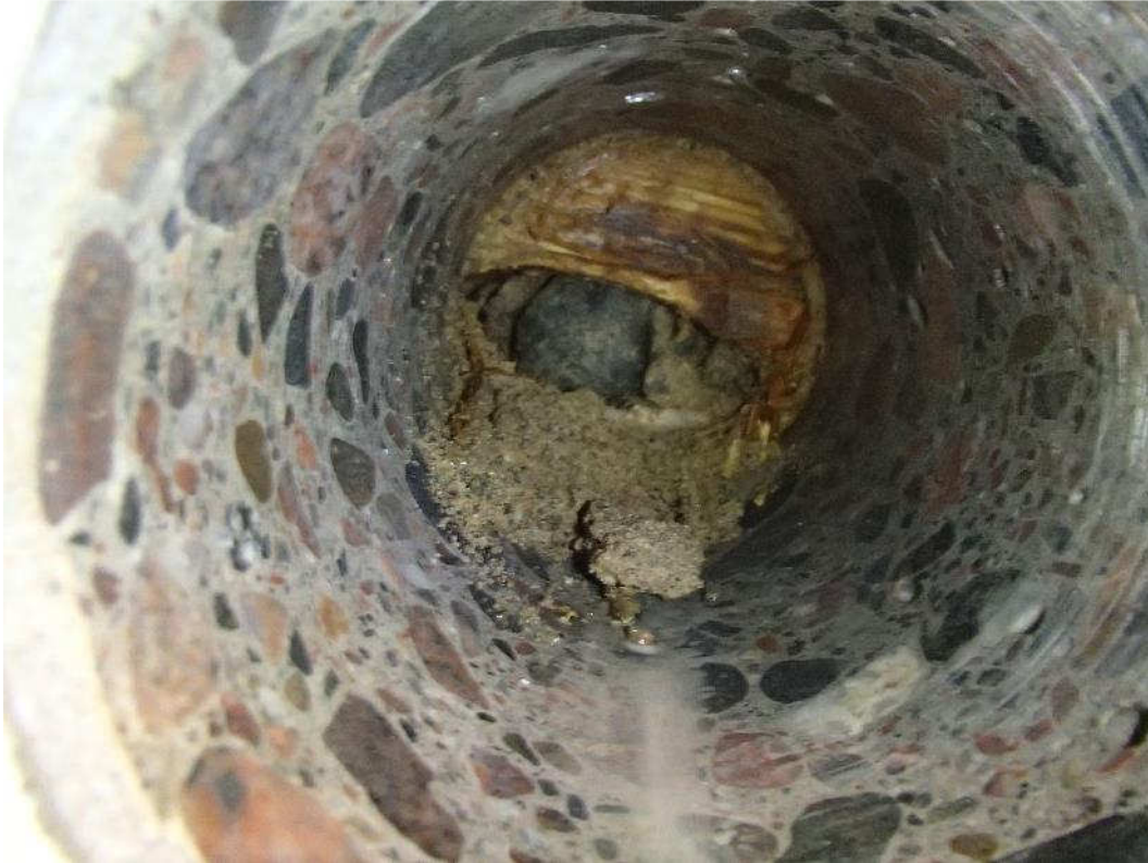
Kuva 86. Rakenneavaus maanastaiseen seinään miesten pukuhuoneesta.
