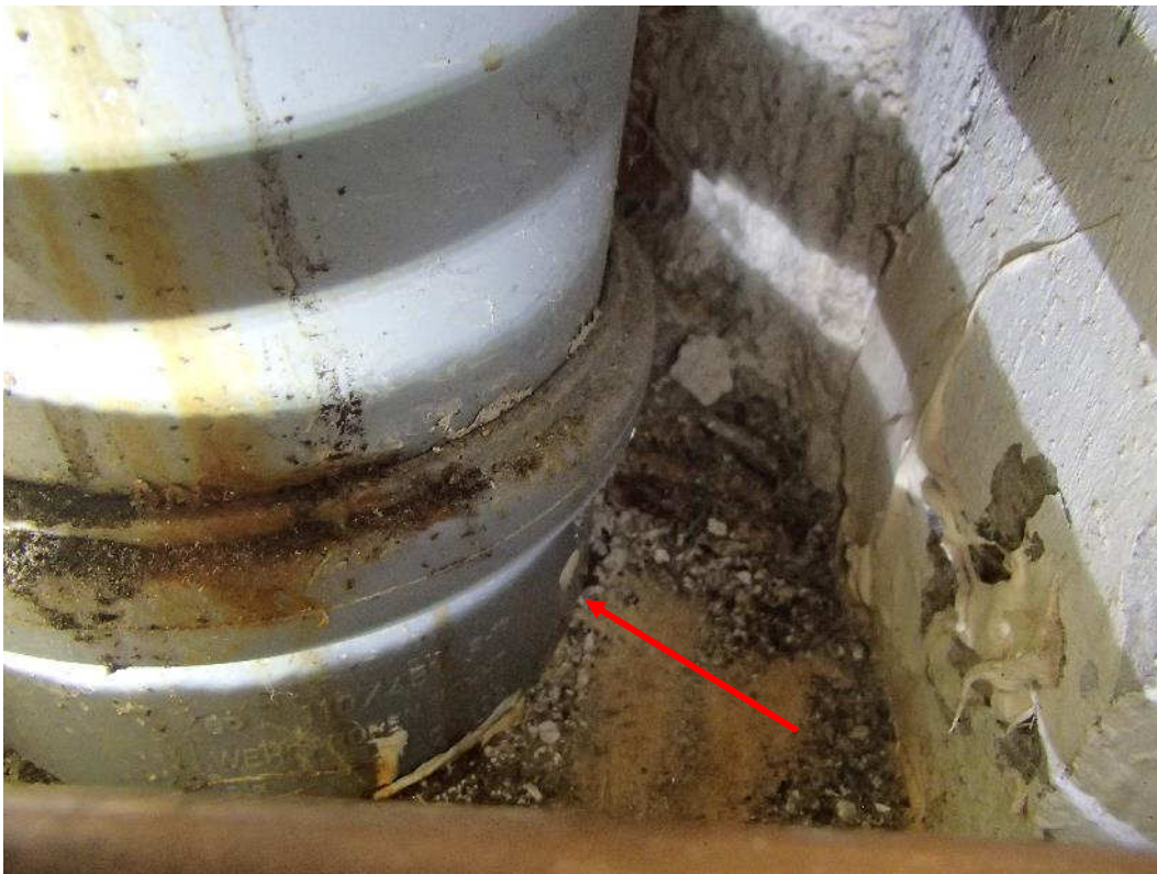
Kuva 92. Kotitalousluokan läpivienti alapohjaan.
