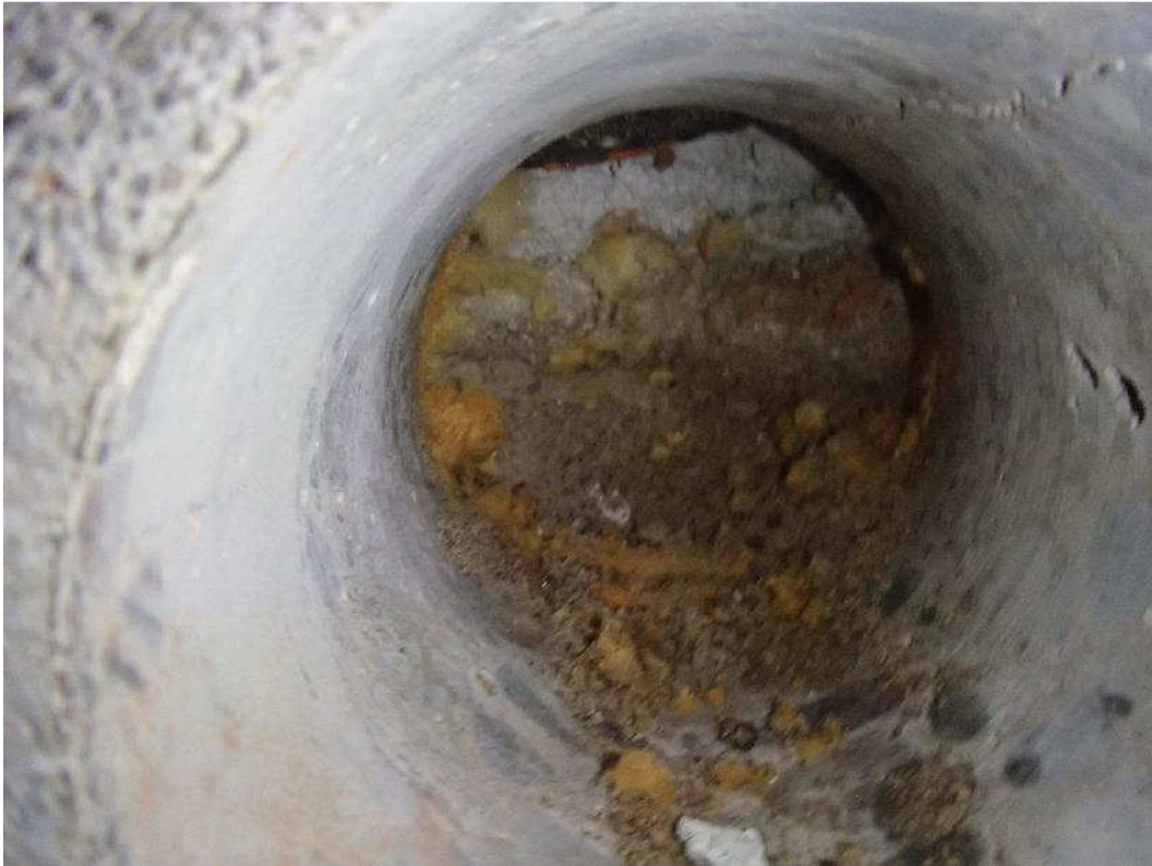
Kuva 34. Rakenneavaus vuonna 1967 rakennetun osan vanhaan sokkelirakenteeseen.
