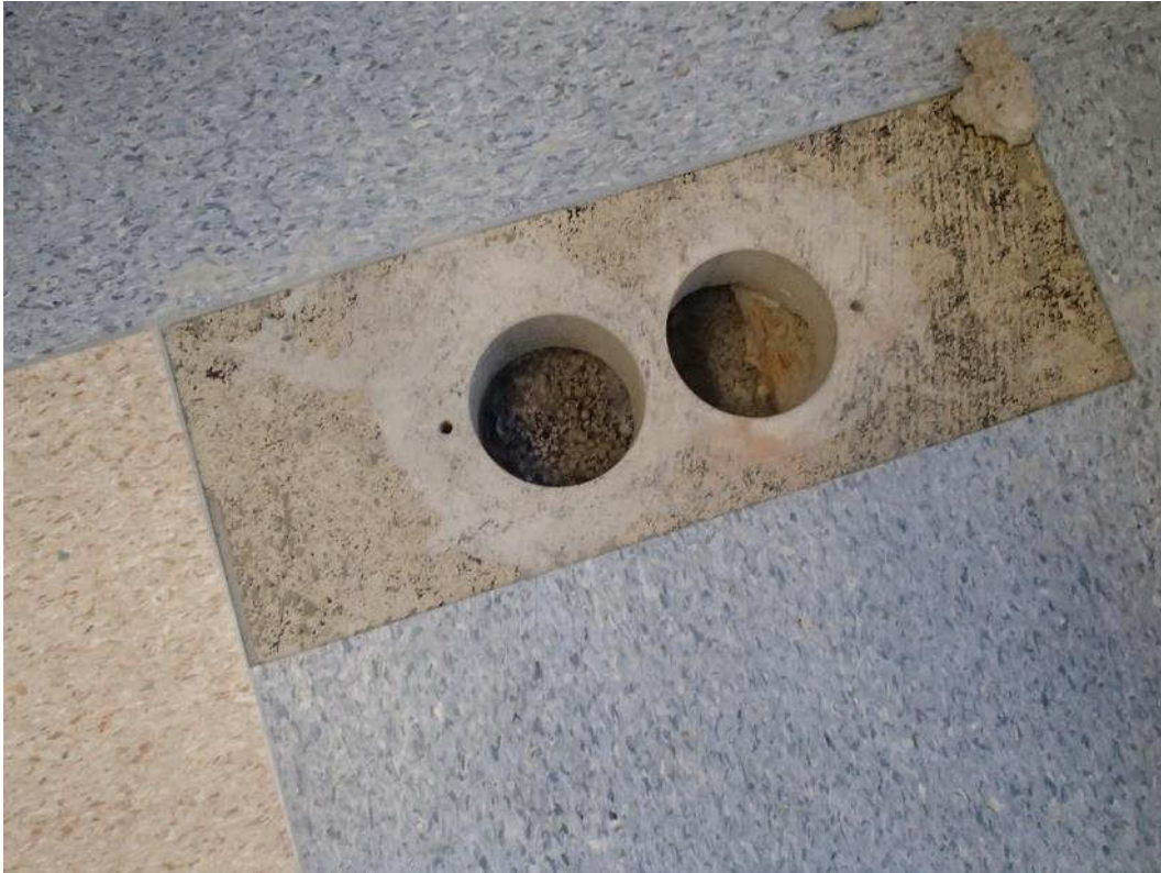
Kuva 76. Rakenneavaus luokkahuoneen 54 alapohjaan ulkovaipparakenteiden viereen.
