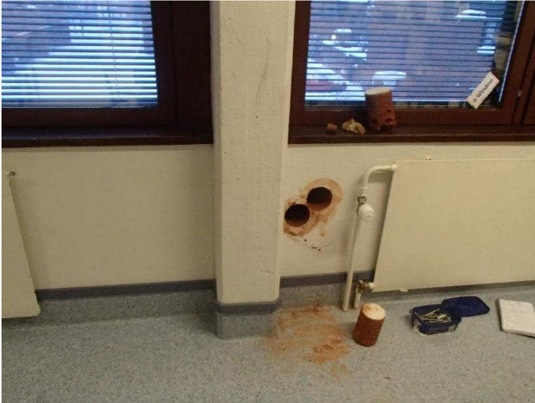
Kuva 74. Yleiskuva välipohjan pintamateriaalista.
