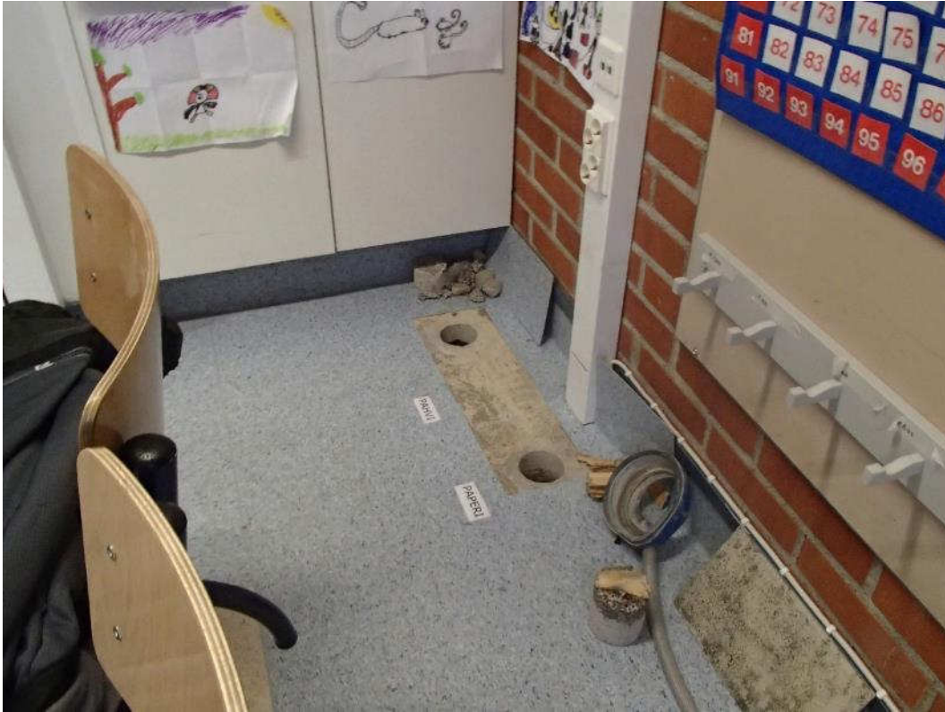
Kuva 79. Rakenneavaus luokkahuoneen 54 alapohjaan sisäseinän vieressä.
