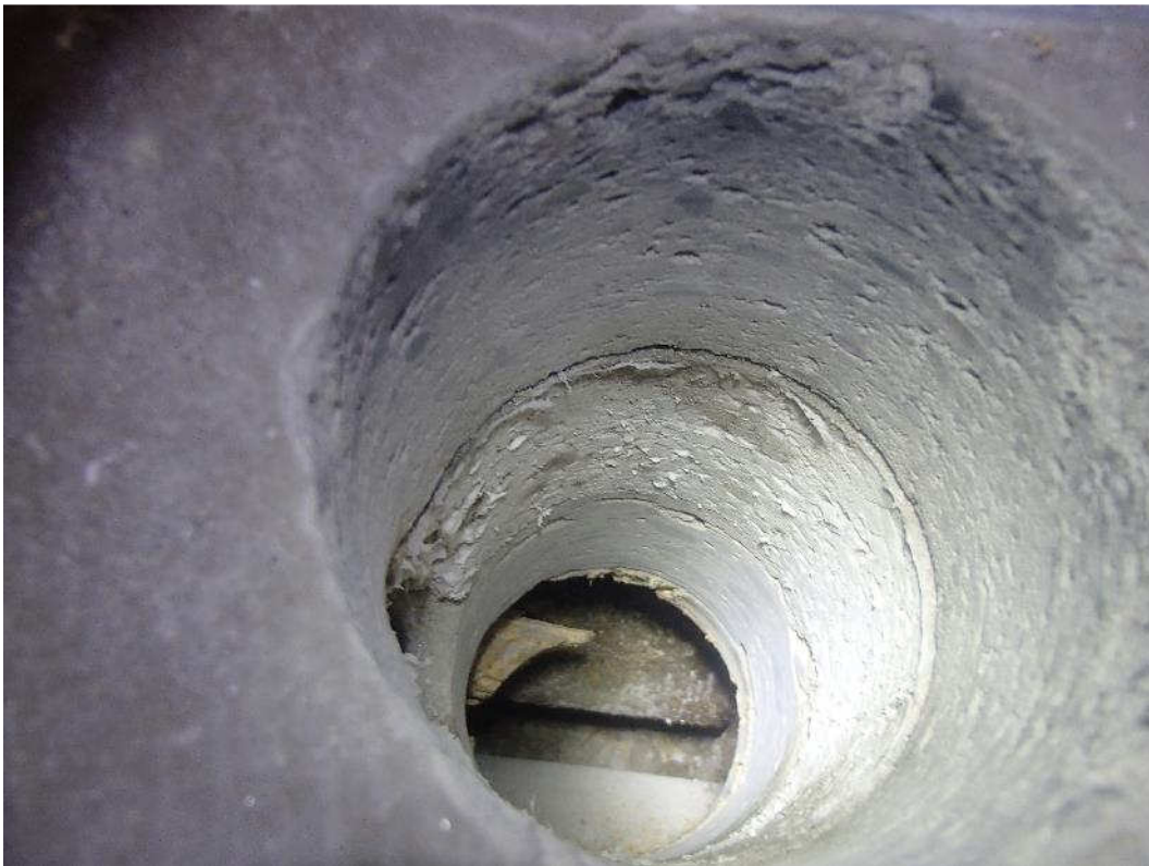
Kuva 128. Rakenneavaus luokan 62 alapohjaan putkikanaalin kohdalta.
