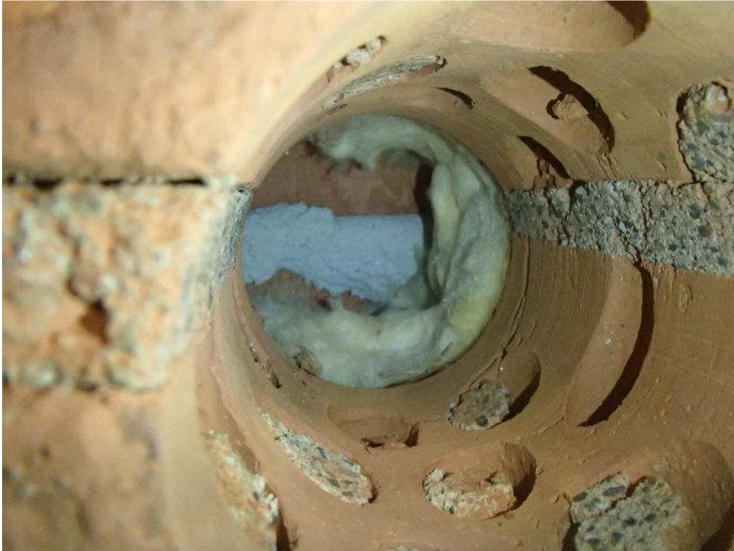
Kuva 33. Rakenneavaus vuonna 1967 rakennetun osan vanhaan ulkovaipparakenteeseen.
