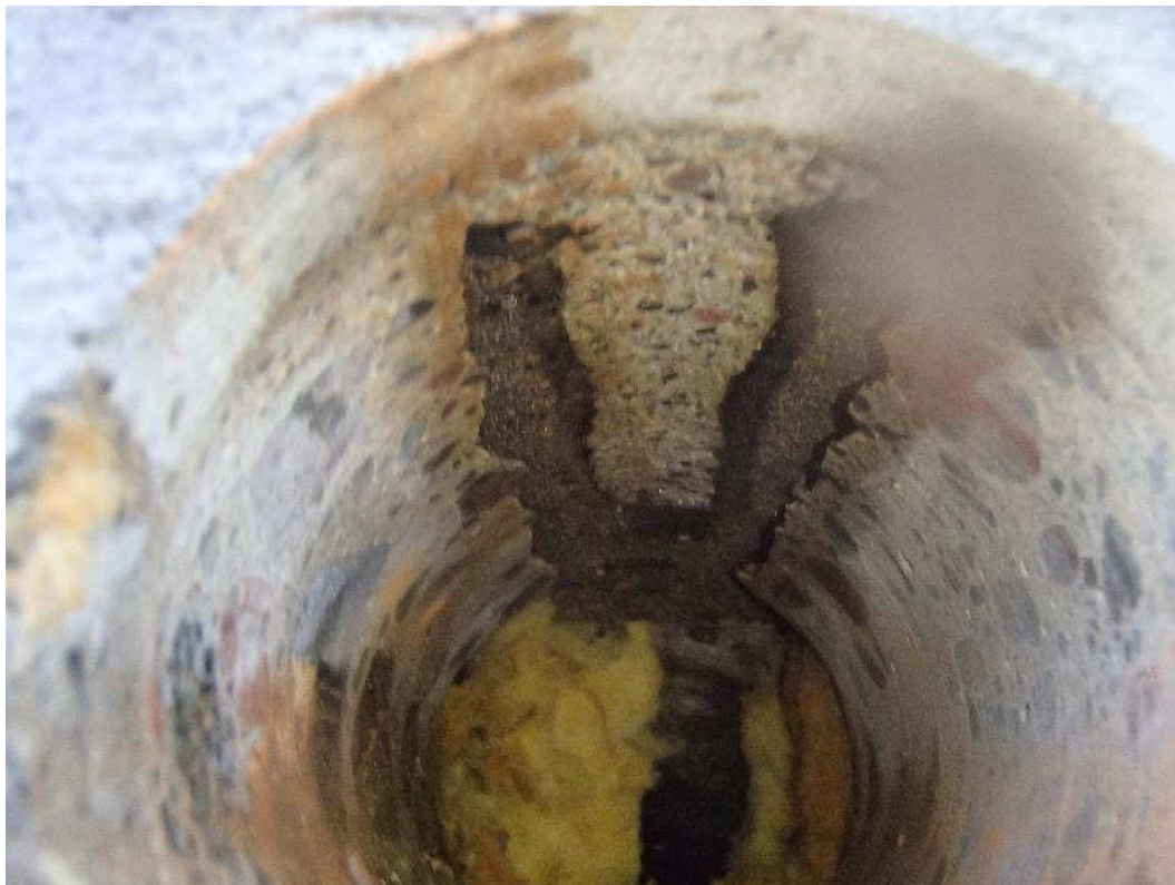
Kuva 5. Rakenneavaus vuonna 1967 rakennetun osan sokkelirakenteeseen.
