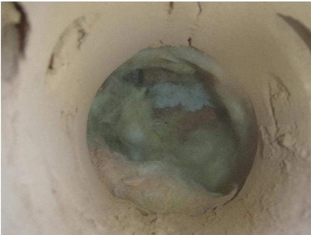
Kuva 4. Rakenneavaus vuonna 1967 rakennetun osan ulkovaipparakenteeseen.
