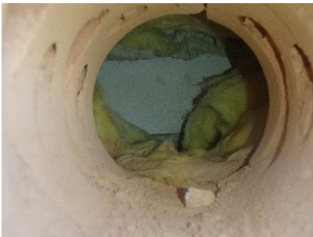
Kuva 96. Rakenneavaus vuonna 1976 rakennetun osan ulkovaipparakenteeseen.
