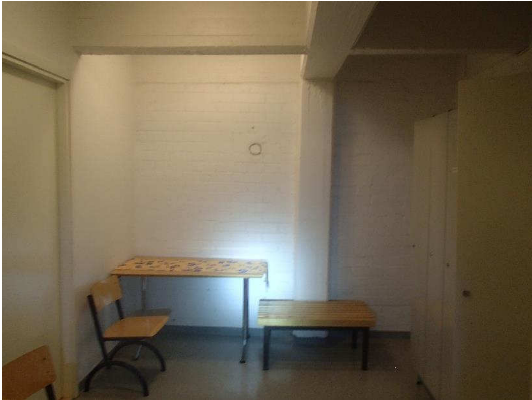
Kuva 93. Yleiskuva maanvastaisesta seinästä.
